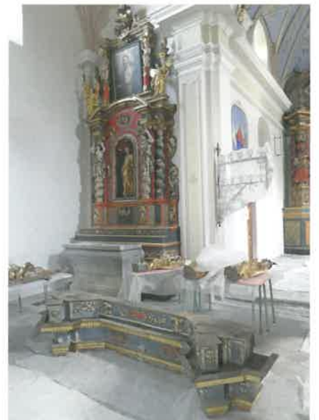
Vue du chantier et du retable du Sacré-Coeur restauré.
