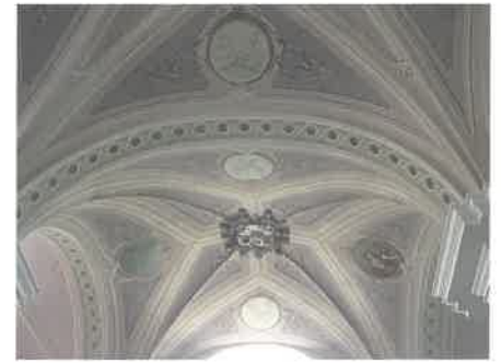
La voûte centrale des tribunes après restauration.
