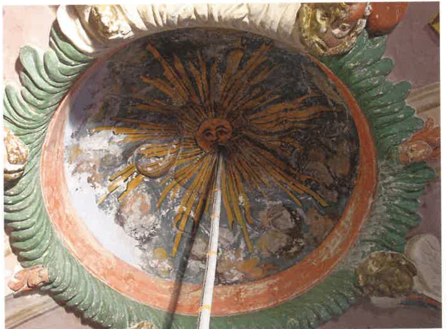
Les motifs polychromes du dôme de la nef de l'église d'Hauteville-Gondon en cours de dégage-ment.
