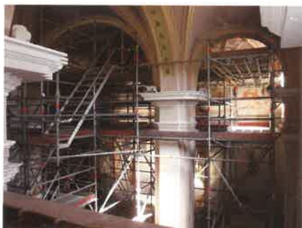
Vue du chantier de la nef; l'échafaudage.
