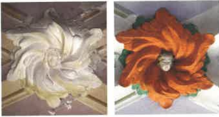
Détail d'une clef de la voûte avant et après dégage-ment de la polychromie.
